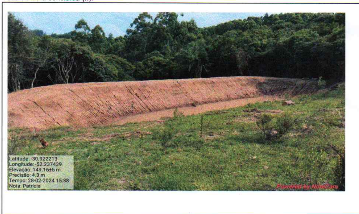
Foto da obra concluída (II):
